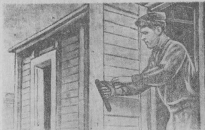
Строительство полевых вагончиков для целины.
