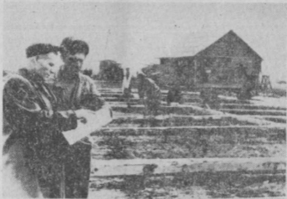
Строительство жилых домов в совхозе «Булаевский». 1954 г.
